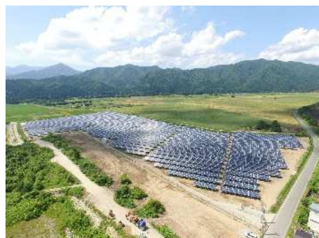
メガソーラー新設工事 (山形県最上町)
